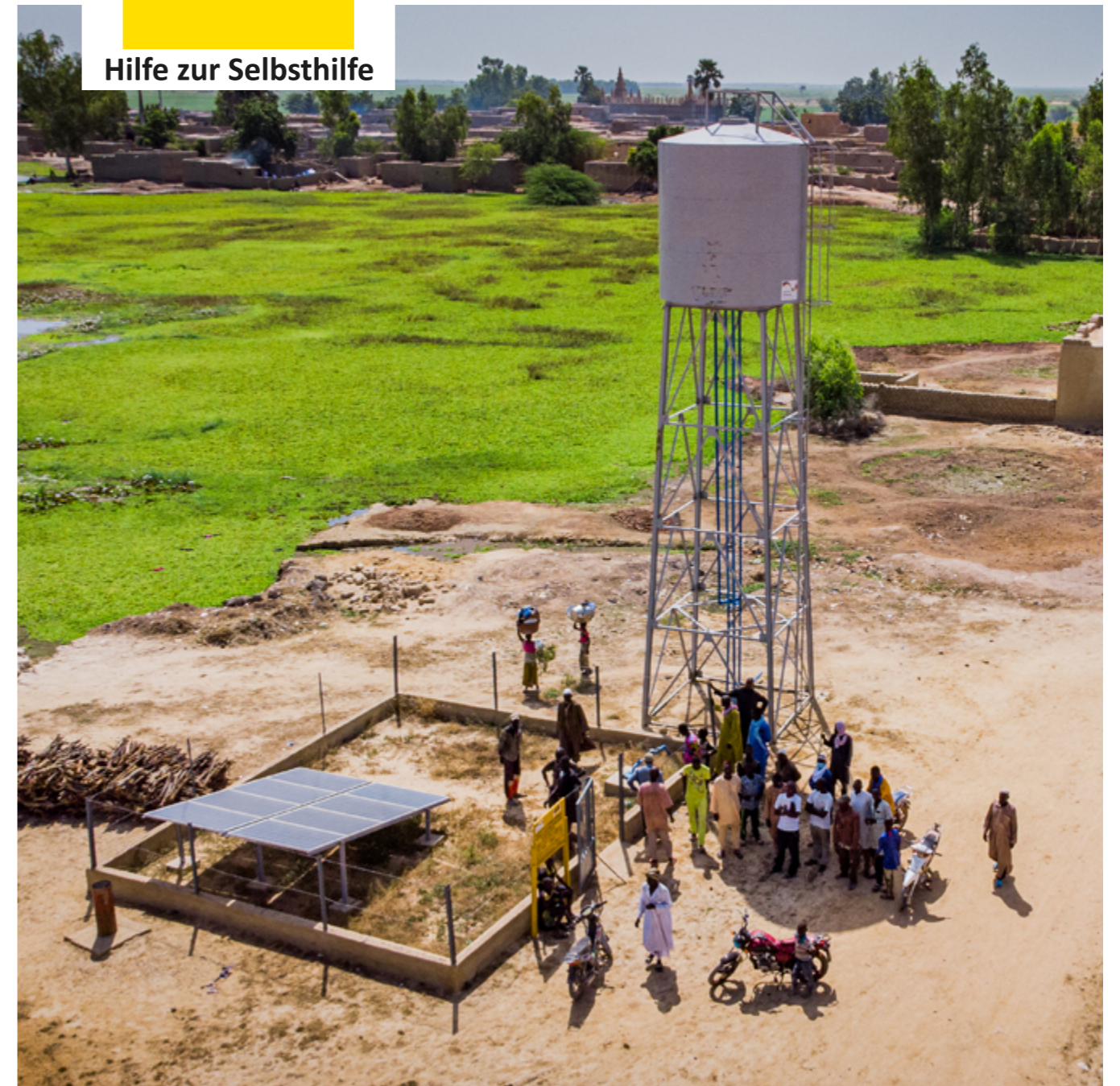
Solarbrunnen helfen bei einer nachhaltigen Wasserversorgung. Mit Solarenergie können Pumpen betrieben werden, die das Wasser aus der Tiefe nach oben befördern.
